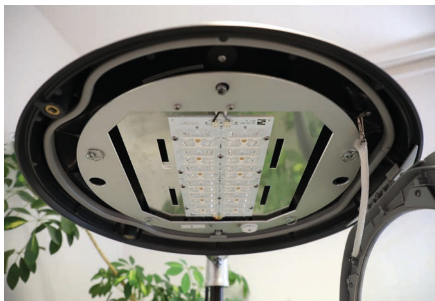
Die aktuellen Ausschreibungen betreffen den Tausch der Ansatzleuchten als weiterführendes Projekt der LED-Umrüstung in der Stadt Wien, wobei die Bauform K2 (hier im Bild) überwiegend für die Straßenbeleuchtung vorgesehen ist.
